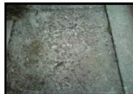
Spalling
