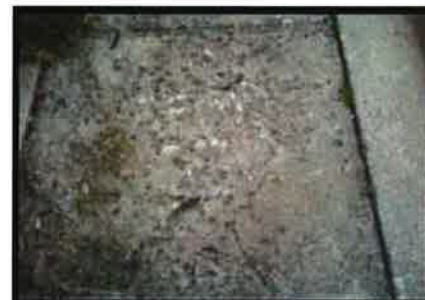
Spalling
