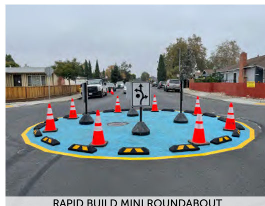
RAPID BUILD MINI ROUNDABOUT
